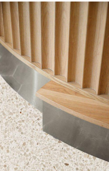
Buffeter Rustfritt stål sokkel, lys eikelaminat, terrasso kompositttopplate
