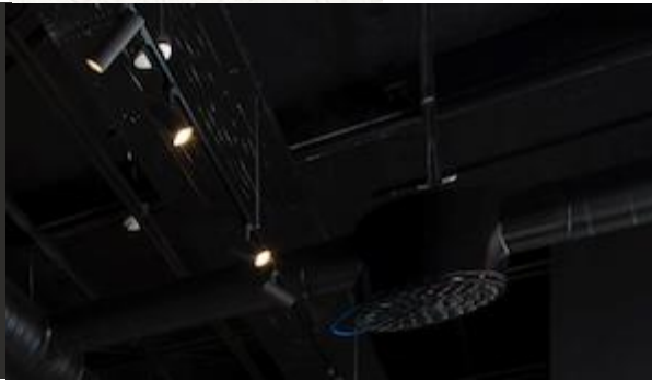
Åpen himling malt Direktemonterte absorbenter. All synlig teknikk fargelakkeres på NCS S 8500-N
